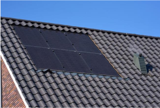
-In het vlak- van de dakbedekking
